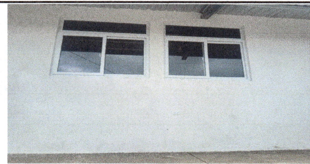
Foto 5: Ventana de PVC
